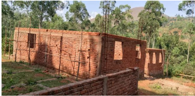
Elévation des murs et chainages supérieurs charpente en bois
